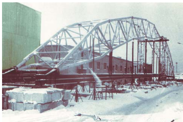
Натурные испытания арки для завода "Севкабель" пролётом 109 м.
