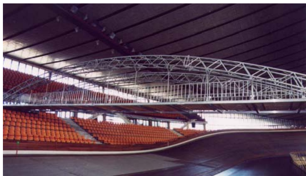
Мост в здании велотрека в Крылатском.
