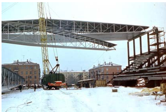
Монтаж алюминиевого покрытия Ледового дворца в Москве.
