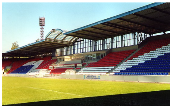
Северная трибуна стадиона "Сатурн".
