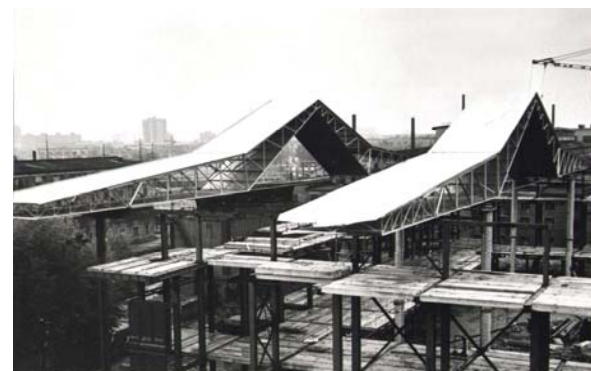
Монтаж блоков Выставочного павильона площадью 504 кв.м.
